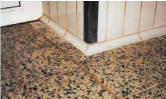
Gemakkelijk schoon te maken scheiding tussen muur en vloer
